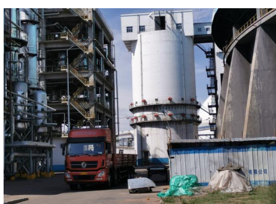
厂内燃料煤筒仓
