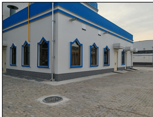
新建天然气锅炉房
