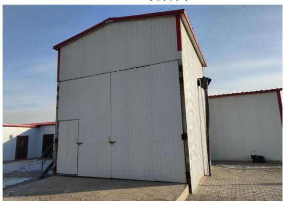
污泥压滤车间
