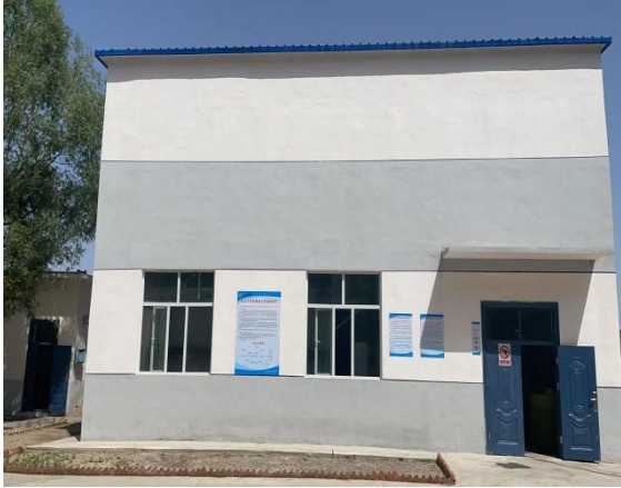
污水处理车间
