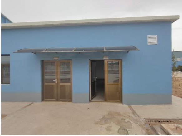
格栅间、水泵房
