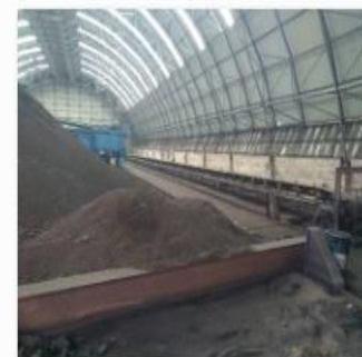
堆煤场内 (1).jpg
