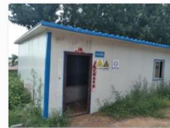
污水处理设施.jpg
