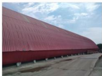
堆煤场外观.jpg
