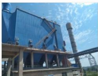
大除尘器2 (2).ina
