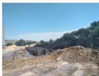
新建煤泥及煤粉堆场 (3).jpg
