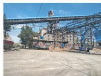
运煤栈桥.jpg
