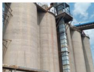
石灰石2、砂岩、铁岩、页岩配 料库 (2).jpg
