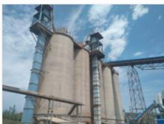
石灰石2、砂岩、铁岩、页岩配 料库 (1).jpg
