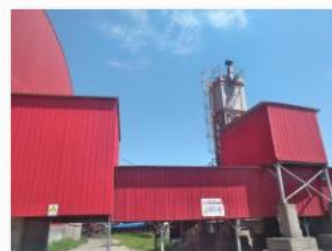
运煤栈桥及除尘 (1).jpg
