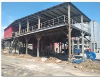
新建煤泥及煤粉堆场 (4).jpg
