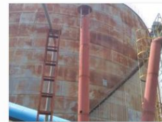
铁矿石除尘 (1).jpg
