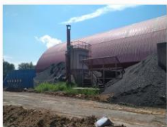
新建煤泥及煤粉堆场 (2).jpg
