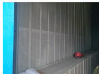
风机房防噪 (2).jpg
