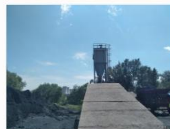
运煤栈桥及除尘 (2).jpg
