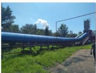
运煤栈桥及除尘 (3).jpg
