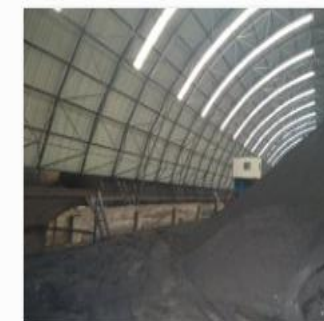
堆煤场内 (2).jpg
