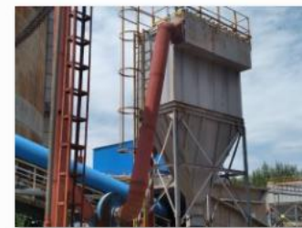
铁矿石除尘 (2).jpg
