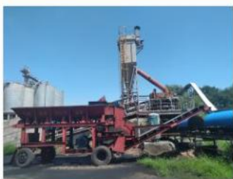
运煤栈桥及除尘 (4).jpg
