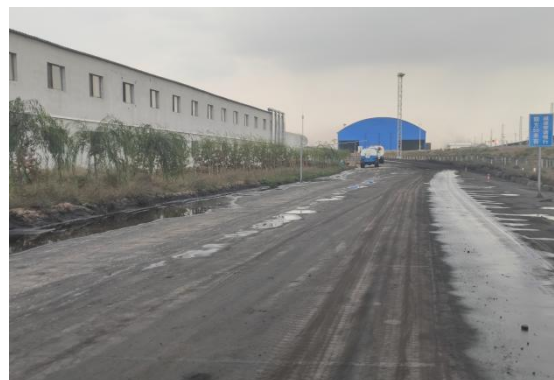
场内道路硬化
