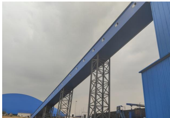
全封闭输煤栈桥
