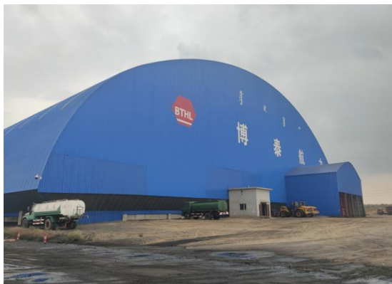
全封闭储煤棚
