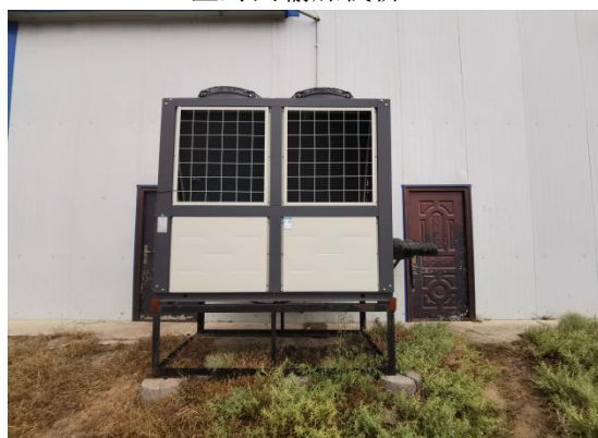
空气能热泵及电锅炉
