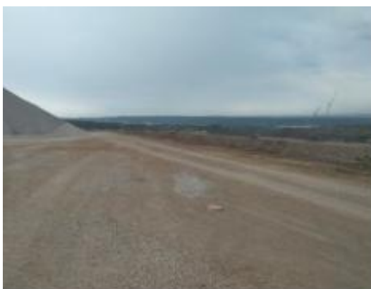
进厂道路硬化
