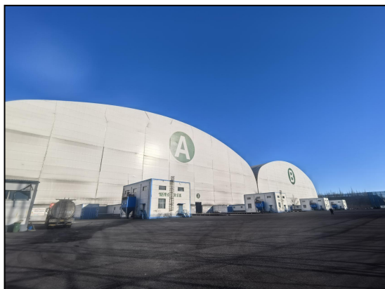
全封闭储煤棚
