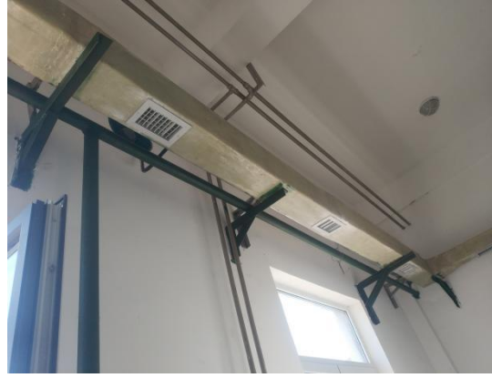
臭气收集系统
