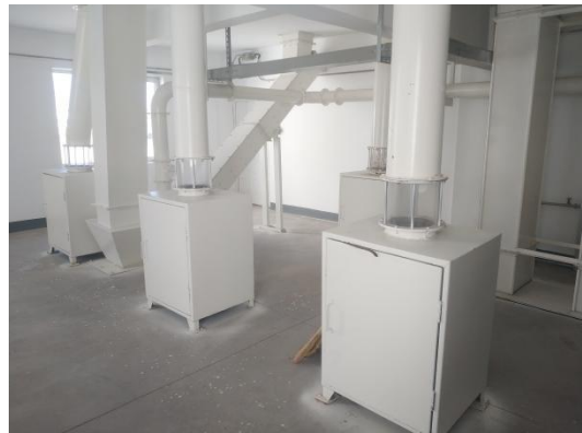
原粮破碎系统除尘收集口
