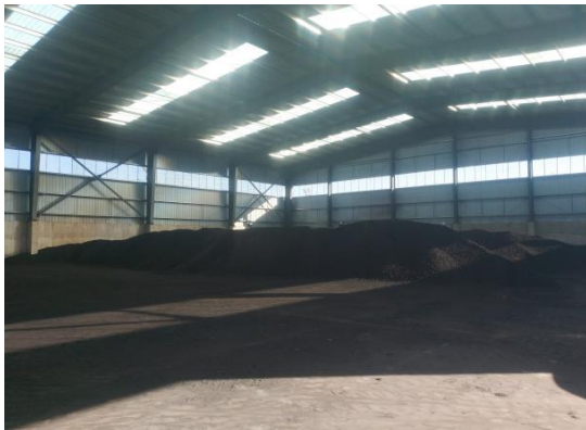
全封闭储煤棚
