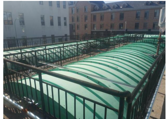
污水主反应池
