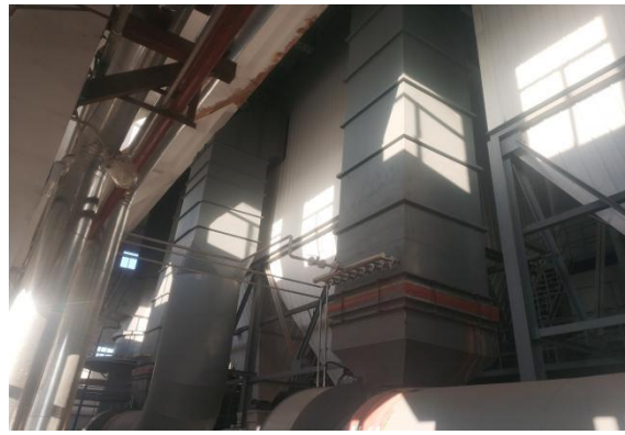
脱硝设备及布袋除尘器
