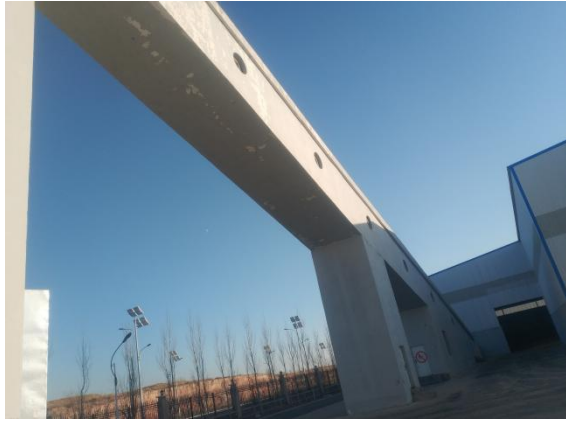
全封闭运煤栈桥
