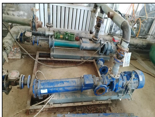
拆除污泥脱水机房旧泵
