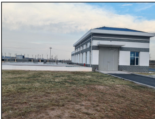
回用水池及加压泵房
