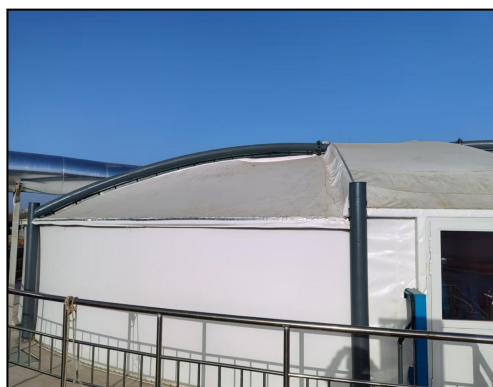
污泥浓缩池封闭式反吊膜
