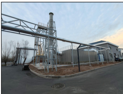
生物滤池除臭系统排气筒
