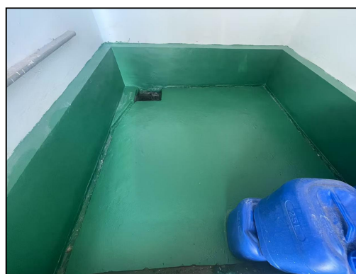
危废间内防渗及集液池
