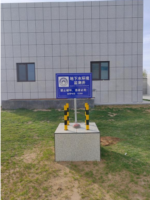
地下水监测井
