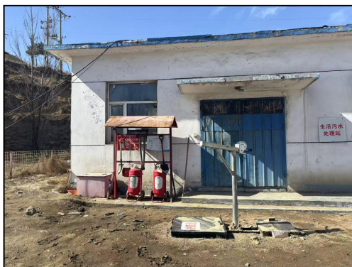
生活污水处理站
