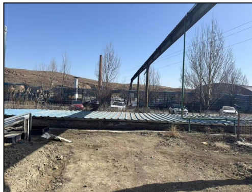
生活污水处理站储水池
