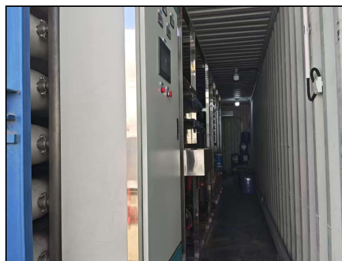
矿井水处理站地面防渗
