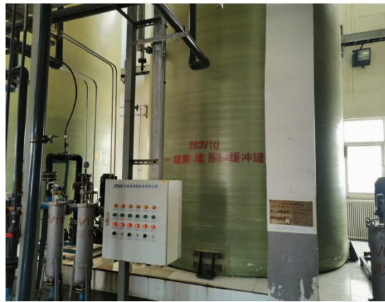
超滤、纳滤原液缓冲罐
