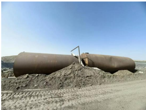
排土场矿坑水储存罐
