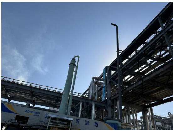
罐区油气回收装置
