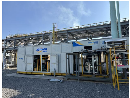
罐区油气回收装置
