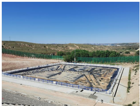
渗滤液调节池
