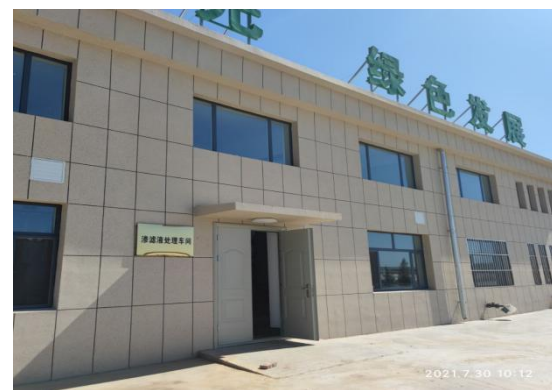
渗滤液处理车间
