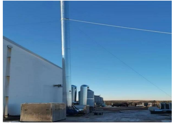
MVR 碱洗处理装置
