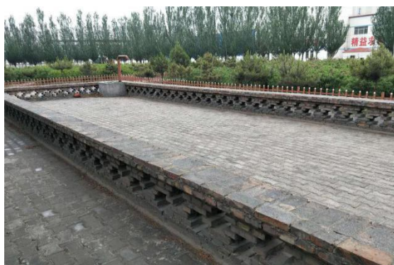
应急消防水池
