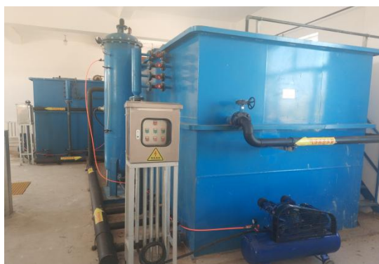
溶气式气浮机
