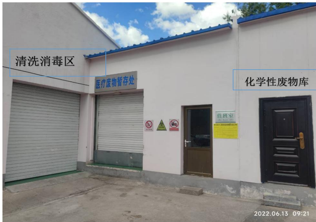
医疗垃圾暂存库
