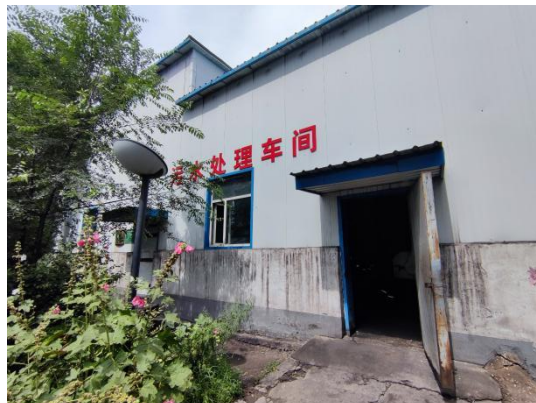
生活污水处理车间
